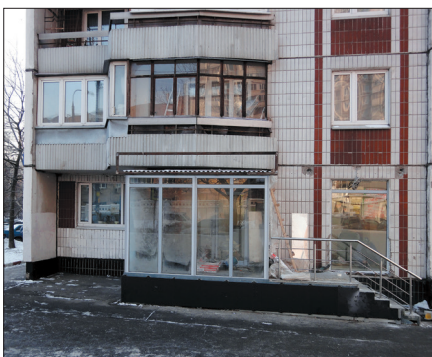
Входная группа в подвальные (цокольные или первые этажи зданий) в пределах земельного участка относящегося к общему имуществу.
