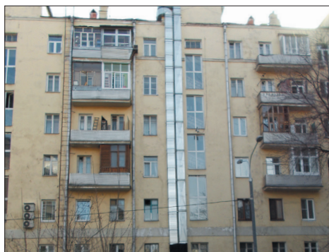
Устройство на фасаде многоквартирного дома вентиляционных коробов.
