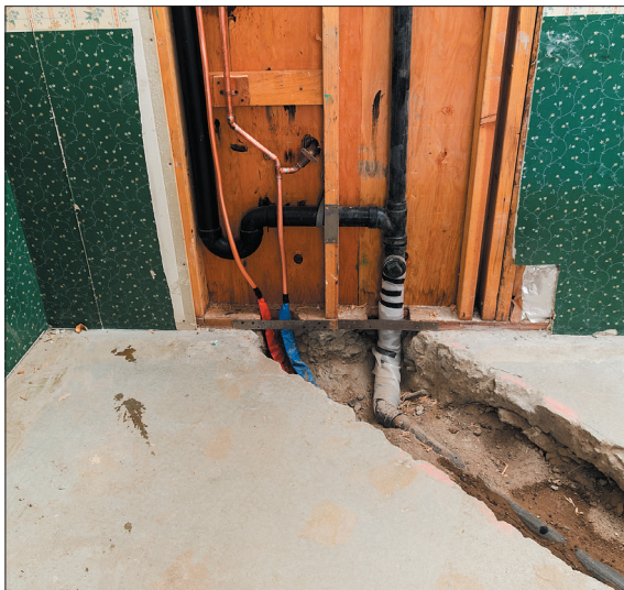
Устройство полов с подогревом от общедомовых систем горячего водоснабжения и (или) отопления.
