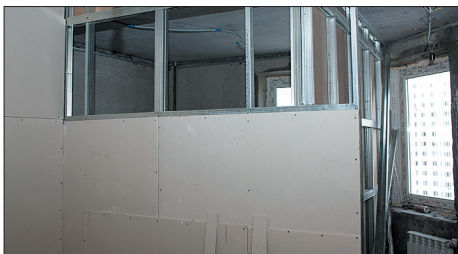
Монтаж и/или демонтаж несущих перегородок.
