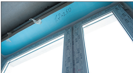
Замена окон без изменения оконного проема
