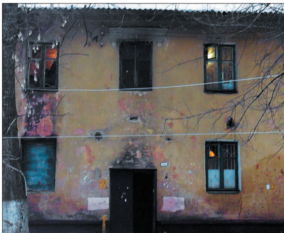
Мероприятия (работы) по переустройству и (или) перепланировке в домах, признанных в установленном порядке аварийными.
